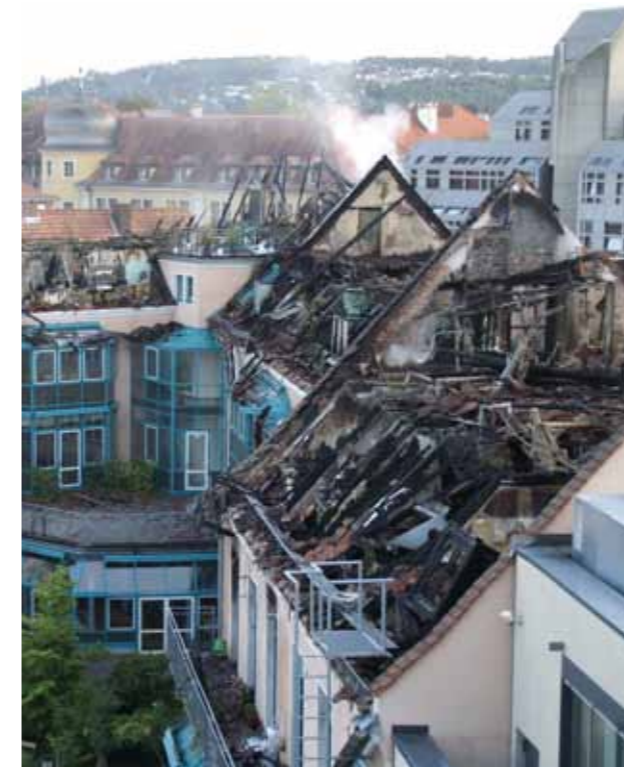
Nach dem Großbrand: Am nächsten Morgen ist das Ausmaß der Schäden sichtbar.
