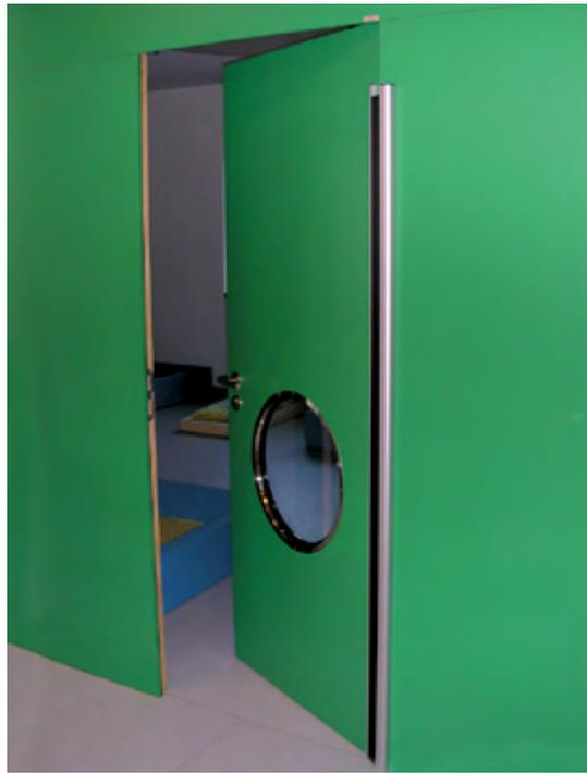
Abb. 15: Tür mit Absicherung der Nebenschließkante (Rundprofil)
